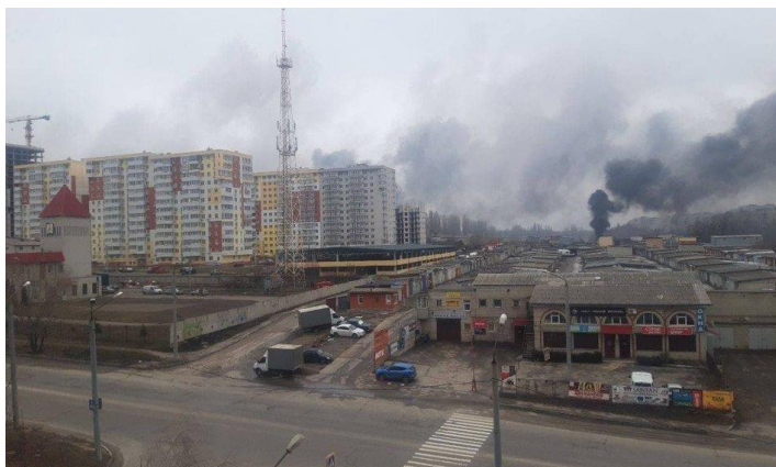
Харків. Руйнувань зазнали багатоповерхівки на вул. Наталії Ужвій, Бучми та інших.
